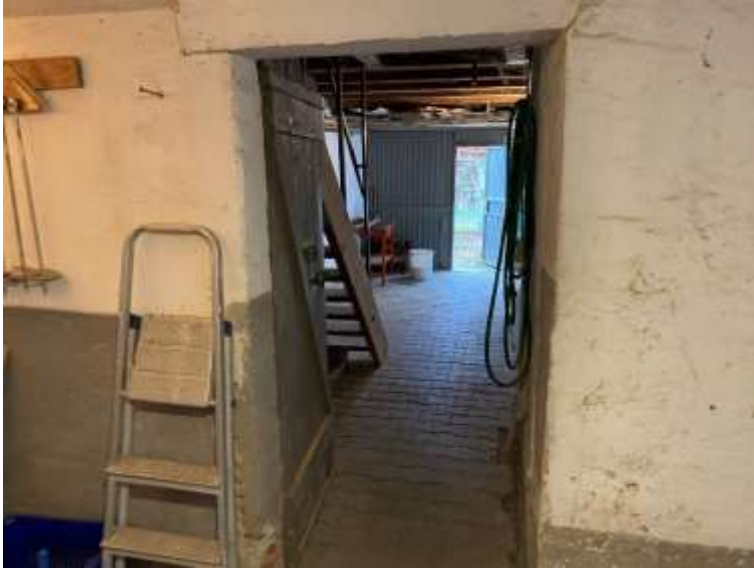
Übergang Abstellraum 1 (EG) zu Garage
