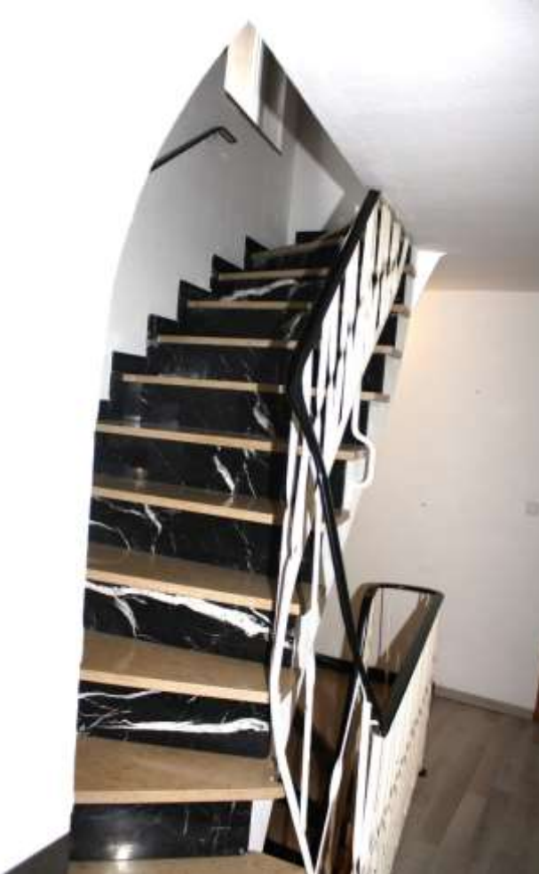
Massive Betontreppen mit Steinplatten von OG1 zu OG2
