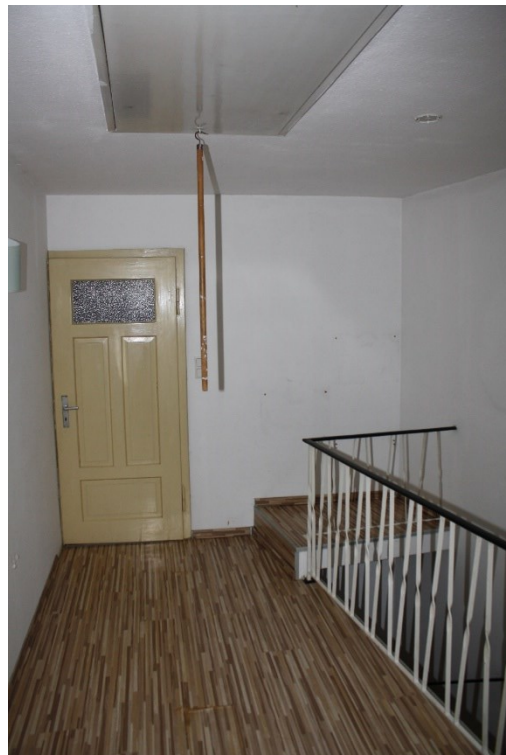
Flur OG2 Zugang Abstell- und HW-Raum
