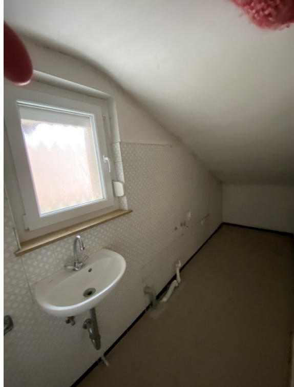
Hauswirtschaftsraum / Waschküche OG2
